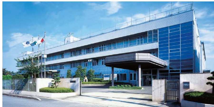
■東洋電機(株)神屋工場
