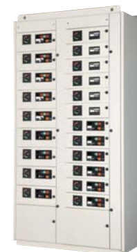
▲モータコントロールセンタ
