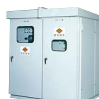
▲屋外受配電盤
